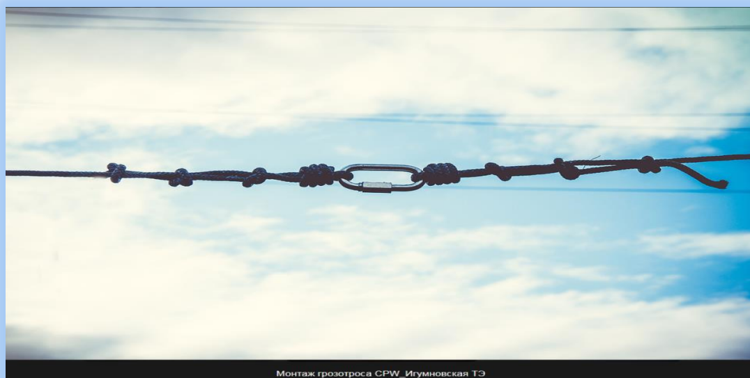
Монтаж грозотроса CPW_Игумновская ТЭ
